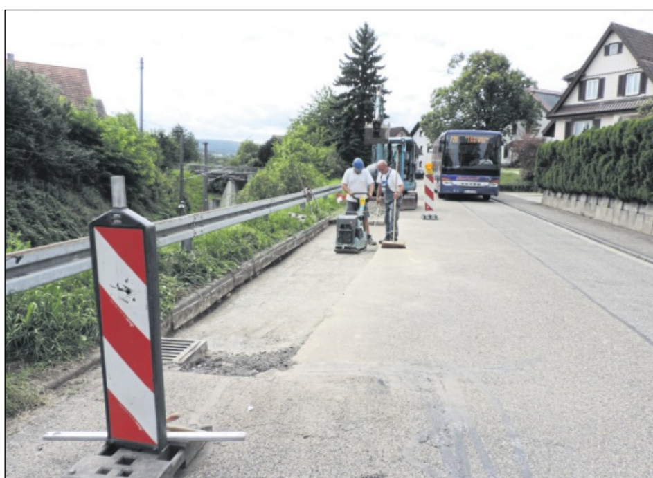
ABGESENKT hat sich die Ittersbacher Bahnhofstraße, wo der Busverkehr in den vergangenen Jahren stark zugenommen hat. Foto: Weber
